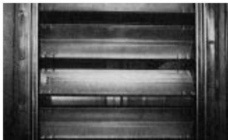
FIGURE 30. Veuillez vous assurer que les lames de registre s'ouvrent et se ferment correctement et qu'elles présentent un dégagement de rotation suffisant.
