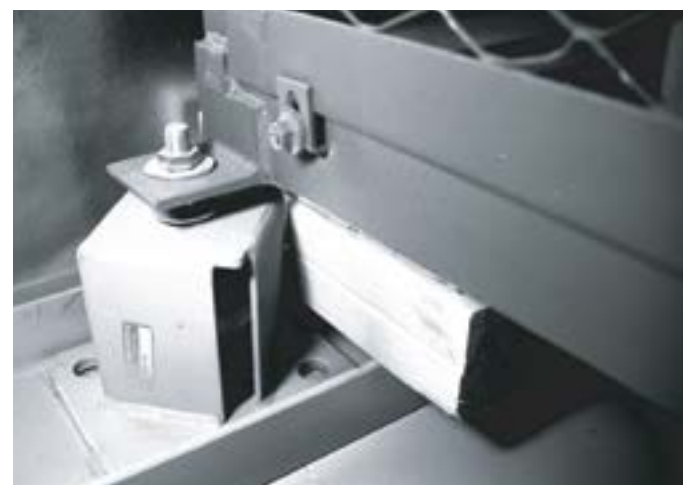
FIGURE 28. En option, les ventilateurs peuvent être montés sur des supports antisismiques.
