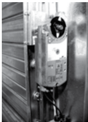
FIGURE 31. Actionneur de registre.
