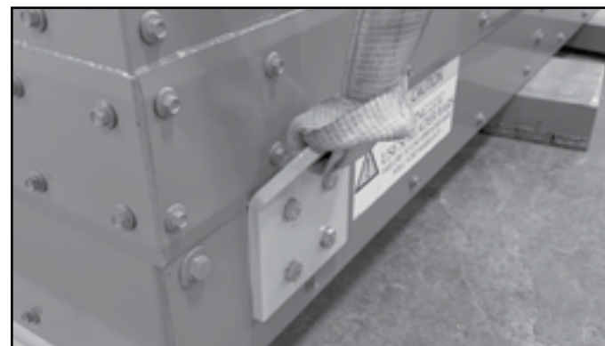
FIGURE 2. Soulevez les modules uniquement à l'aide des pattes situées à la base de chaque module. Ne pas utiliser de chariot élévateur. REMARQUE: Palans à chaîne utilisés pour mettre à niveau l'unité.
