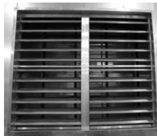
FIGURE 11. Veuillez vous assurer que les lames de registre s'ouvrent et se ferment correctement et qu'elles présentent un dégagement de rotation suffisant.
