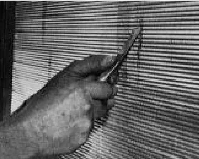
FIGURE 16. Un peigne à ailettes peut être utilisé pour enlever la matière enchevêtrée dans les ailettes, ainsi que pour redresser les ailettes. Mais normalement, rincer les serpentins avec de l'eau sous pression normale enlèvera la plupart des matières.
