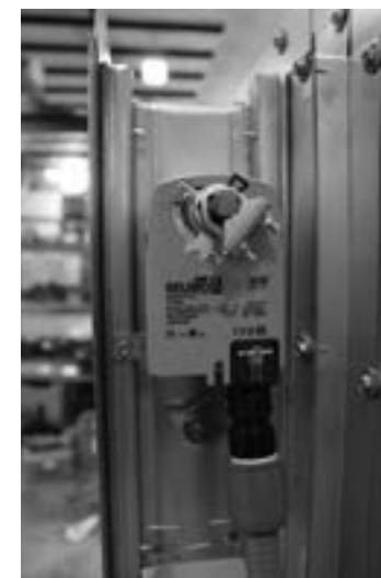
FIGURE 12. Actionneur de registre
