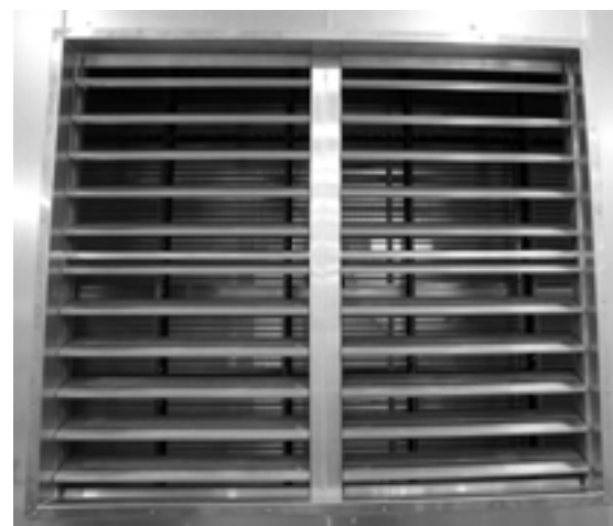
FIGURE 40. Assurez-vous que les lames de l'amortisseur s'ouvrent et se ferment correctement et que le jeu de rotation est suffisant.
