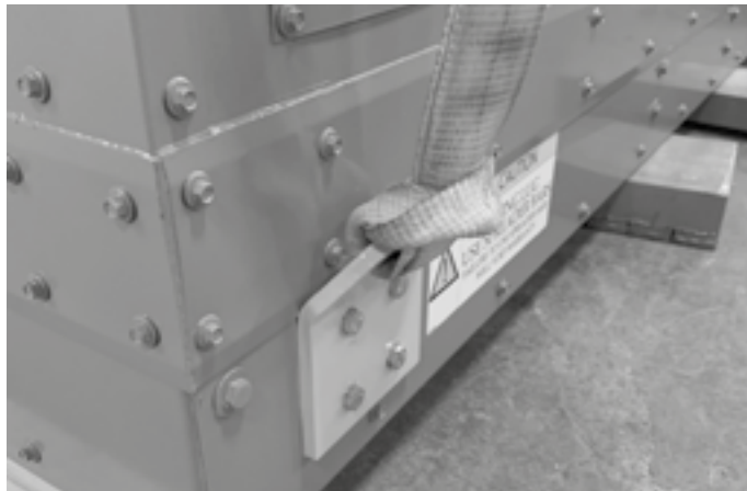
FIGURE 2 Soulevez les unités uniquement avec les anneaux situés à la base de chaque unité. Ne pas utiliser un chariot élévateur. REMARQUE: Les palans à chaîne sont utilisés pour niveler l'unité.
