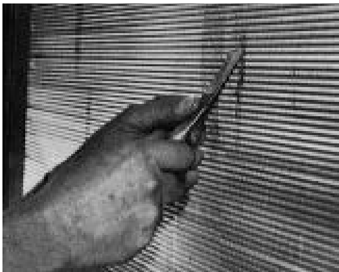
FIGURE 44. Un peigne à ailettes peut être utilisé pour éliminer les matières emmêlées dans les ailettes, ainsi que pour redresser les ailettes. Cependant, un rinçage normal des bobines à l'eau sous pression normale éliminera la plupart des matières.
