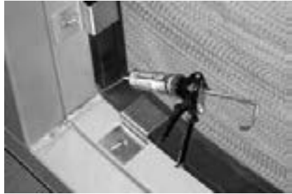
FIGURE 23. Du côté des intempéries de la roue où le joint de face rencontre le joint périphérique aux deux extrémités.
