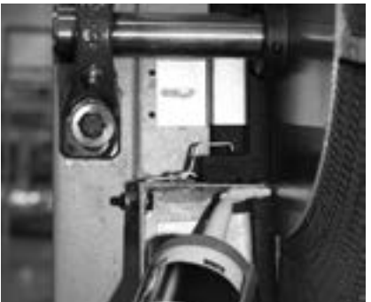
FIGURE 21. Calfeutrez l'espace où le joint de purge bute contre la paroi métallique d'extrémité à la base de la purge.
