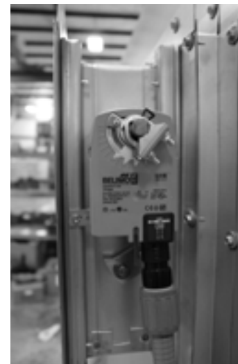
FIGURE 41. Actionneur d'amortisseur
