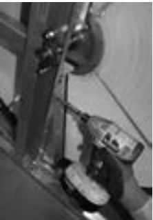
FIGURE 32. Retirez les vis de la section de purge du cadre en tôle.
