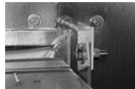
FIGURE 15. Deux dispositifs de retenue en haut du ventilateur fixant le ventilateur au mur.
