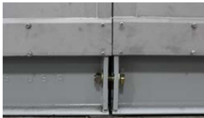
FIGURE 5. Raccord situé sur la base. Utilisez uniquement ces boulons pour tirer les modules ensemble!
