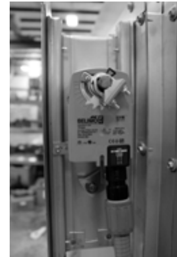
FIGURE 21. Actionneur de registre
