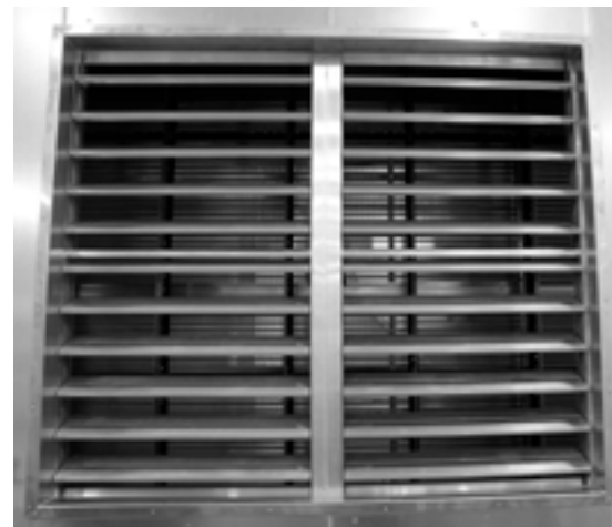
FIGURE 20. Veuillez vous assurer que les lames de registre s'ouvrent et se ferment correctement et qu'elles présentent un dégagement de rotation suffisant.
