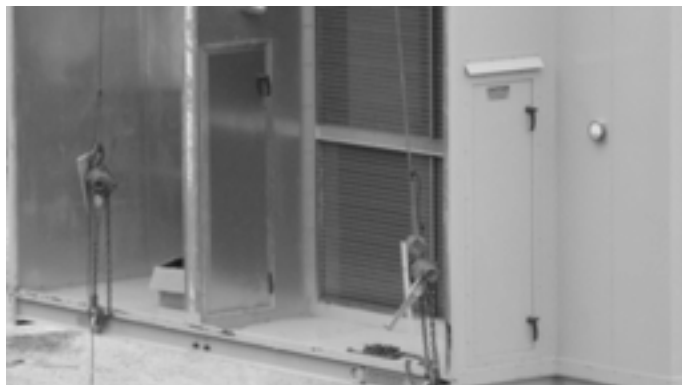
FIGURE 1 Soulevez les modules uniquement à l'aide des pattes situées à la base de chaque module. Ne pas utiliser de chariot élévateur. REMARQUE: Palans à chaîne utilisés pour mettre à niveau l'unité.
