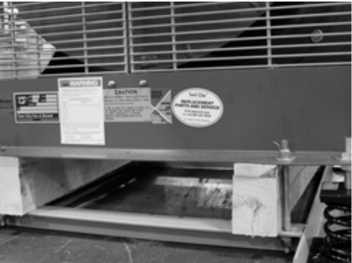
FIGURE 25. Tous les ventilateurs installés dans les systèmes FläktGroup SEMCO sont étiquetés avec des instructions de lubrification qui doivent être suivies. Sur les ventilateurs plus petits, l'étiquette se trouve sur le cadre du ventilateur. *Le modèle/la marque du ventilateur peut varier en fonction du projet.
