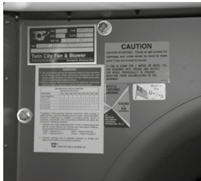
FIGURE 34. L'étiquette de lubrification pour les ventilateurs plus grands se trouve sur le boîtier d'entrée du ventilateur.
