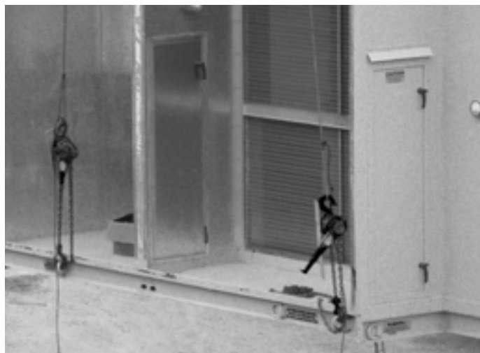
FIGURE 1. Modules de levage uniquement avec des pattes situées à la base de chaque module. N'utilisez pas de chariot élévateur. REMARQUE: Des palans à chaîne sont utilisés pour mettre l'unité à niveau.
