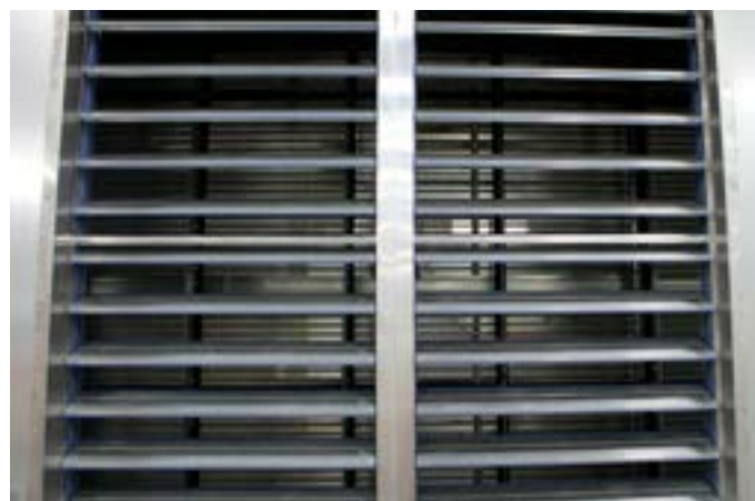
FIGURE 27. Assurez-vous que les pales du registre s'ouvrent et se ferment correctement et qu'elles disposent d'un jeu de rotation frousuffisant.
