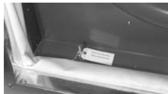
FIGURE 22. Deux dans l'entrée du ventilateur qui boulonnent le ventilateur au rail de base.
