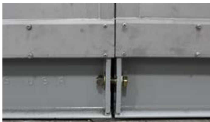
FIGURE 5. Joint de chantier situé sur la base. Utilisez uniquement ces boulons pour assembler les modules.
