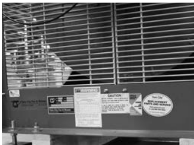
FIGURE 33. Tous les ventilateurs installés dans les systèmes FläktGroup SEMCO sont étiquetés avec des instructions de lubrification qui doivent être suivies. Sur les petits ventilateurs, l'étiquette se trouve sur le cadre du ventilateur.
